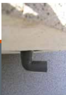
Anschlußmöglichkeit eines 50 mm HT-Rohr
